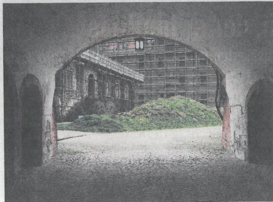
Schutthalde: Blick in den Innenhof des eingerüsteten Schlosses
