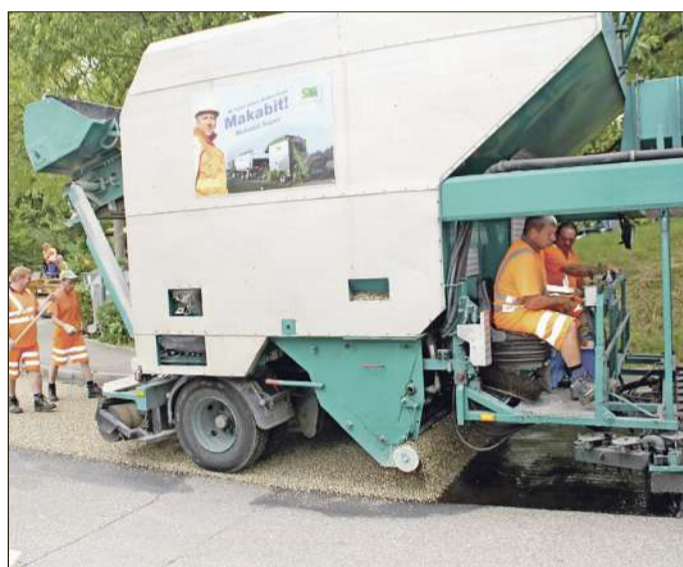
Dieses Spezialfahrzeug versprüht die Bitumenemulsion und streut den Splitt darüber.
